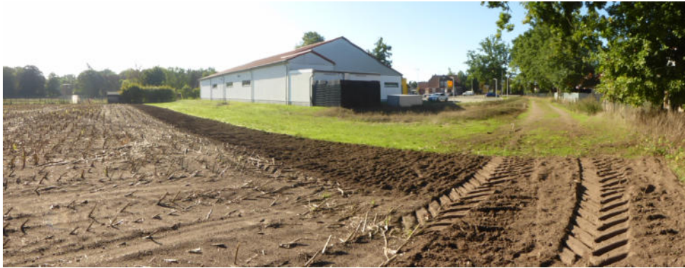
Foto 2: Blick von weiter außerhalb nördlich des Plangebietes auf den NETTO-Markt und das Baugebiet
