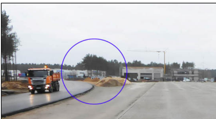
Abb. 4: Flächenzustand im November 2019 (Aufnahmedatum 03.12.2019)
