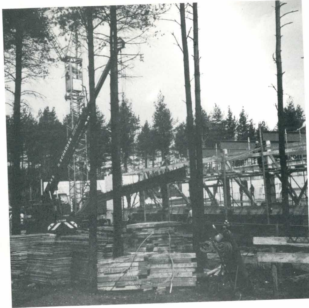
Der Bau wächst empor
