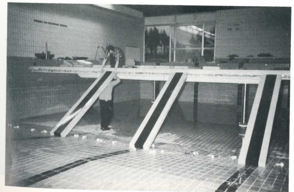
Der Innenausbau im Becken mit der Hebeplattform für Nichtschwimmer
