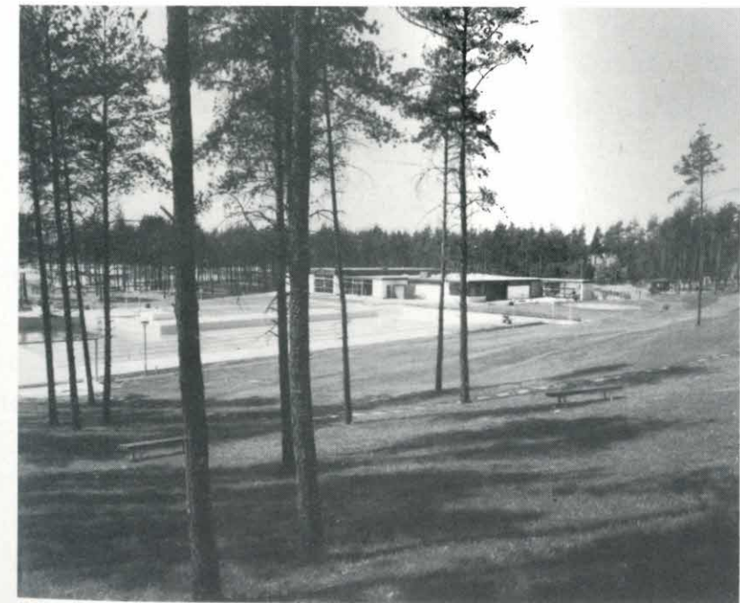
Die Anlage ist fertiggestellt Das Becken wird gefüllt
