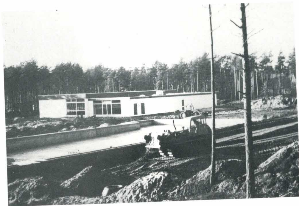
Die Schwimmbecken umgebende Liegewiese wird planiert
