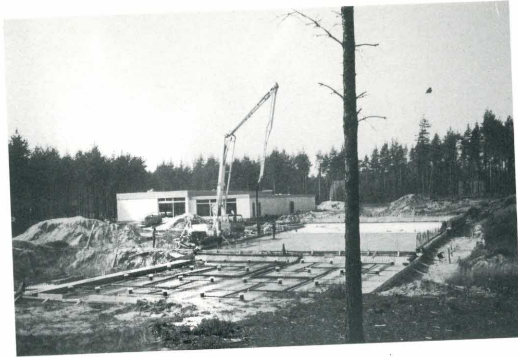
Die Grundplatte mit dem Leitungssystem und der Armierung werden vorbereitet
