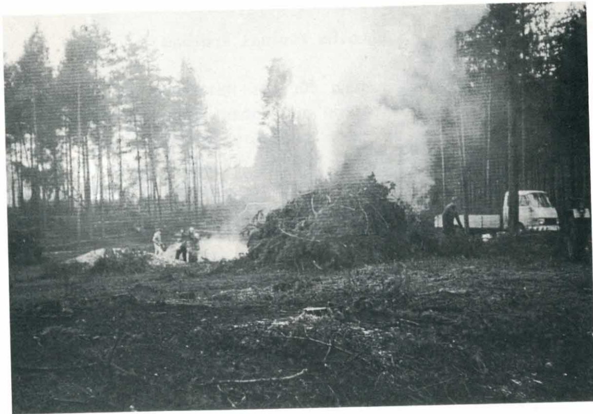
Räumung des Geländes
